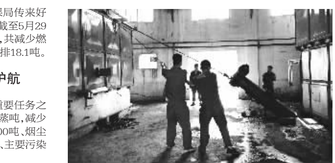
高陵燃煤锅炉拆改现场
