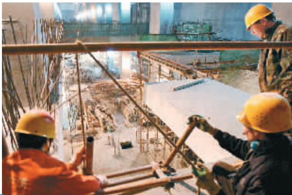
西安地铁二号线北大街车站地下施工现场。 记者 魏影 摄
