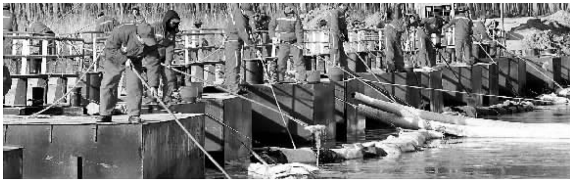
4日,抢险人员使用凝固剂在渭河入黄处打捞泄漏的柴油。新华社发
