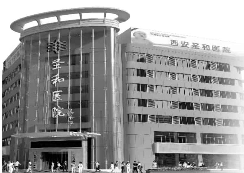
8000平方米的圣和医院门诊大楼
