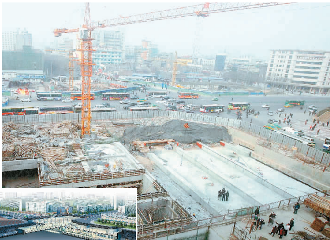
小图:西安地铁二号线北大街车站剖视效果图。 大图:主体结构全部封顶的西安地铁二号线北大街车站。 记者 魏影 摄 2版
